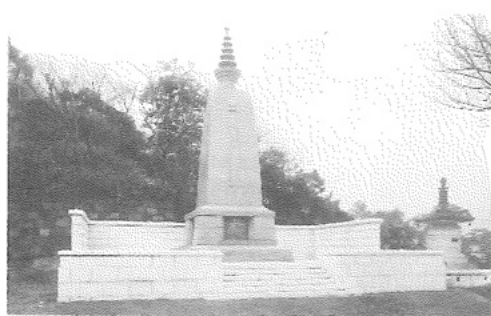
29 土木建築殉難者慰霊塔落成記念 1937年
